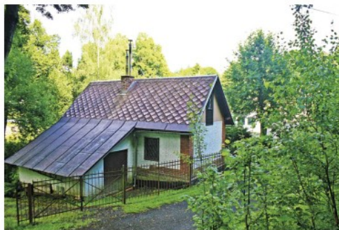
Ev. č. 1, poslední objekt z areálu jatek
