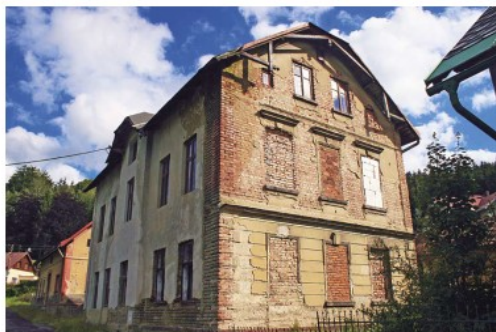
Č. p. 97 ubytovna pro dělníky jatek, snímek z r. 2012 v době opravy fasády
