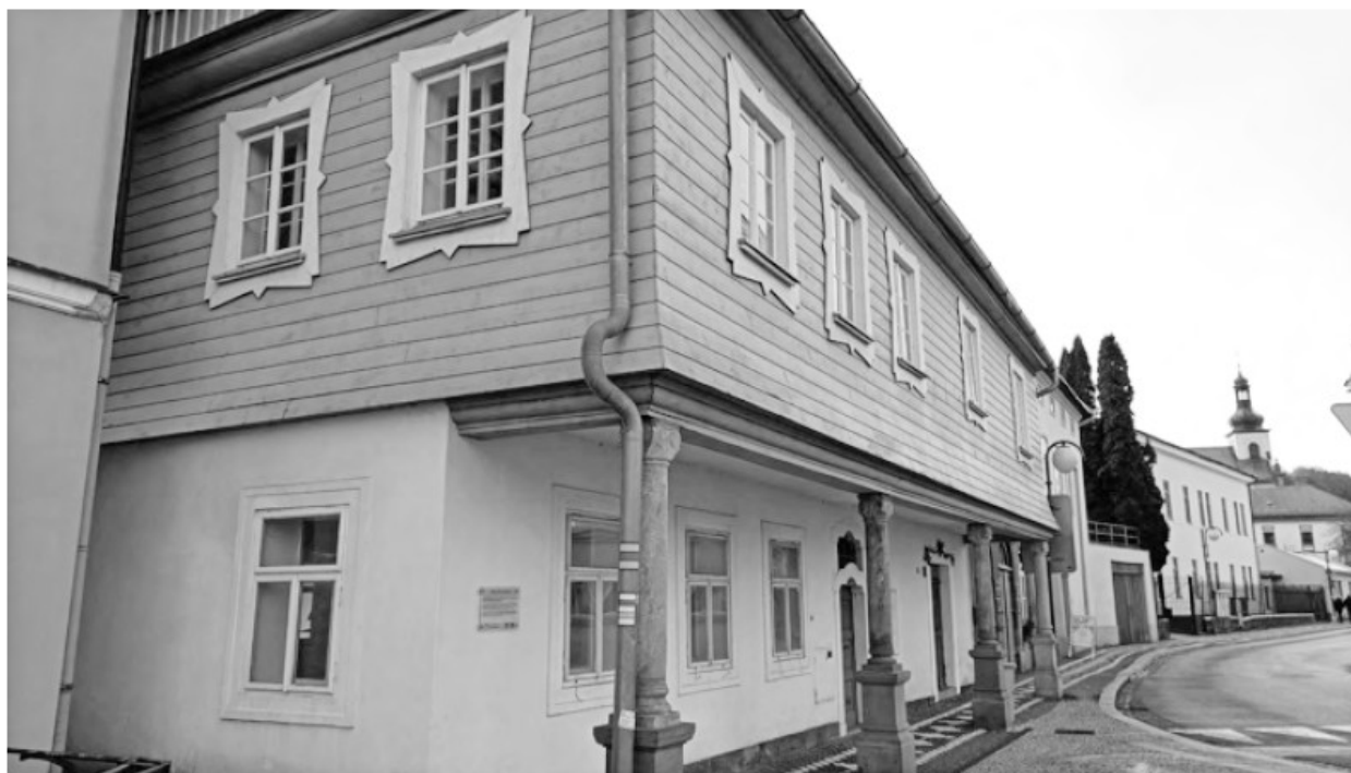
Budova staré radnice č.p. 210. Foto: D. Palátková
